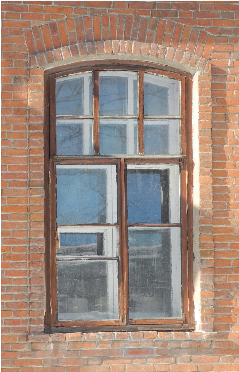
Окно с арочной перемычкой (лучковая арка). Восточный фасад
